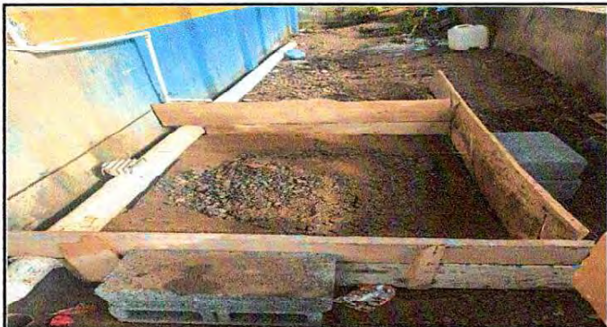
Foto 1: REPARACIÓN DE BASE DE CONCRETO PARA PILA
