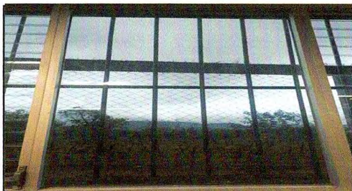
Foto 3: SUSTITUCIÓN DE VIDRIOS
