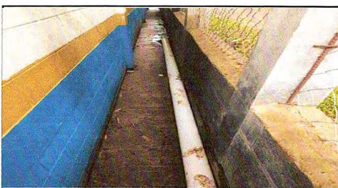
Foto 4: INSTALACIÓN DE TUBERÍA PARA DRENAJE
