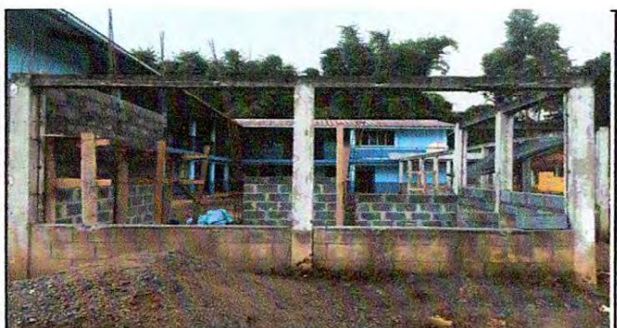
Foto 5: CONTINUACIÓN DE PAREDES DE COCINA
