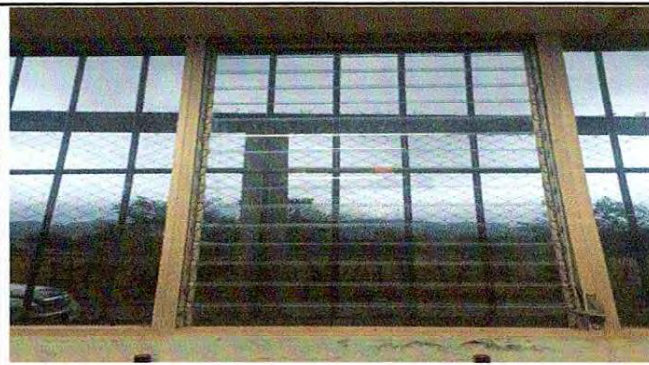
Foto 2: SUSTITUCIÓN DE VIDRIOS
