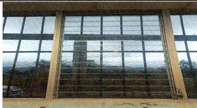
Foto 2: SUSTITUCIÓN DE VIDRIOS
