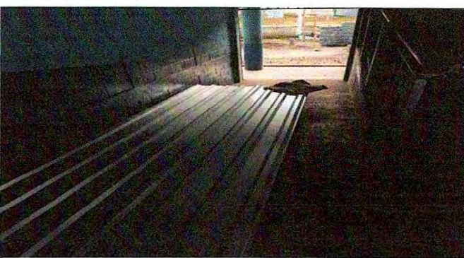
Foto 6: LÁMINAS PARA ENTECHADO.
