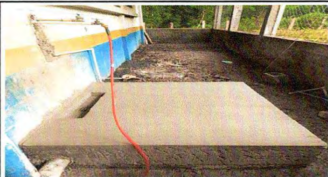
Foto1: REPARACIÓN DE DRENAJE DE PILA
