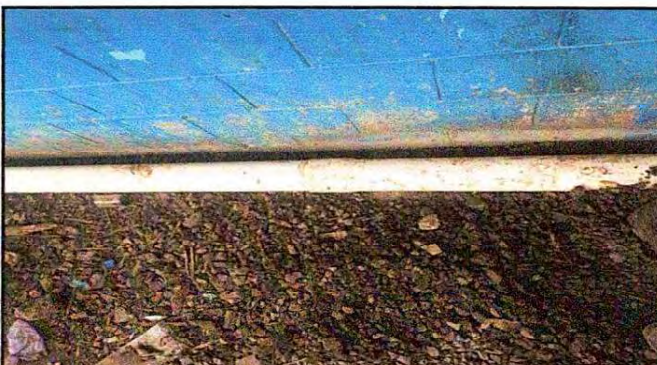
Foto 4: INSTALACIÓN DE TUBERÍA PARA DRENAJE
