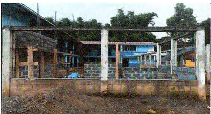
Foto 5: CONTINUACIÓN DE PAREDES DE COCINA
